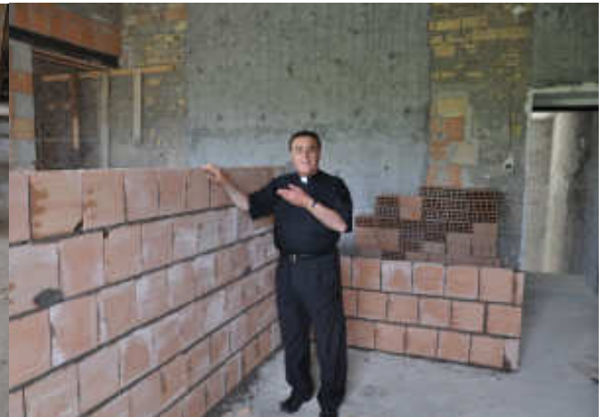
Don Gabriele durante la periodica verifica dei lavori nel locale che diventerà la stanza donata da lui
