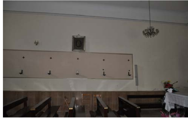
Muro che verrà abbattuto per l'ampliamento
