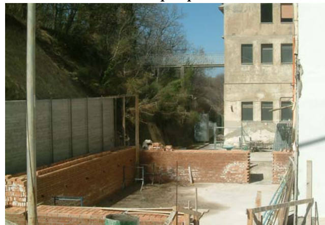
Inizi dei lavori del raddoppio della Chiesa
